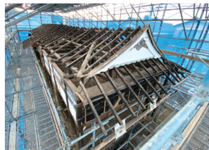
屋根の軸組みが露わになったところ。垂木等の一部は過去の増築工事で切断されていました
