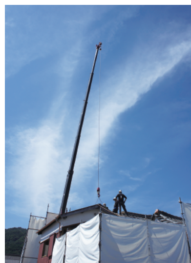
大きなクレーンもやって来ていました。 暑い中屋根の上での作業ご苦労様です！
