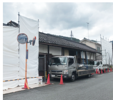
足場が組まれていよいよ工事スタート！
