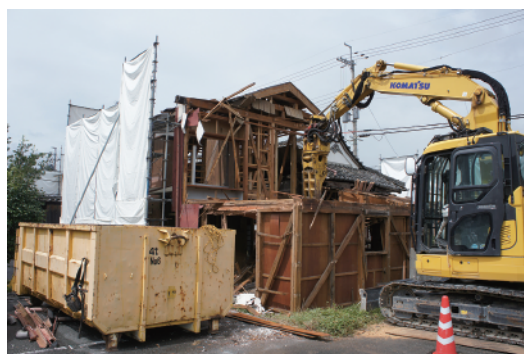
一度はじまると、みるみる内に解体されていきます。 一週間ほどで東側の住宅がなくなりました。
